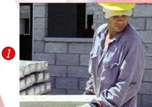
DESCARGA MANUAL EN OBRA
