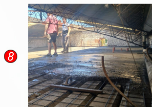
LLENAR CAPA DE COMPRESION (CONSULTAR ESPESOR)
